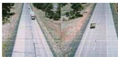
Normál bitumennel épített út
