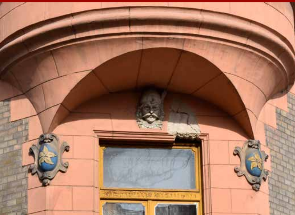
Majolikamázás pirogránit és műkő díszek a hátsó homlokzat egyik konzolos sarokerkélye alatt (fotó: ifj. Gyergyádesz László)
