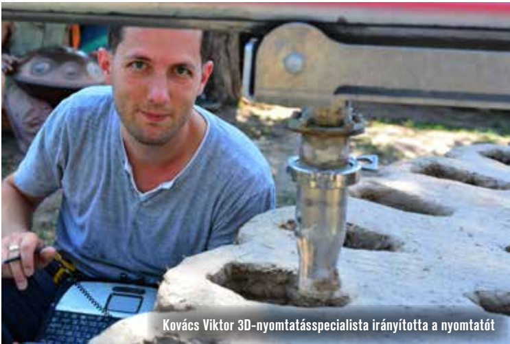
Az utolsó napon fél méter vályog került fel a kis kupolára
